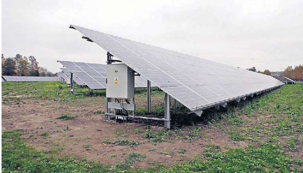
Montaż instalacji fotowoltaicznych powinien być powierzony fachowcom
