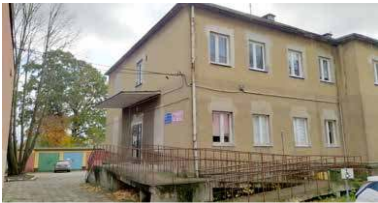
Remont ma zostać przeprowadzony w budynku administracji szpitala i POZ
