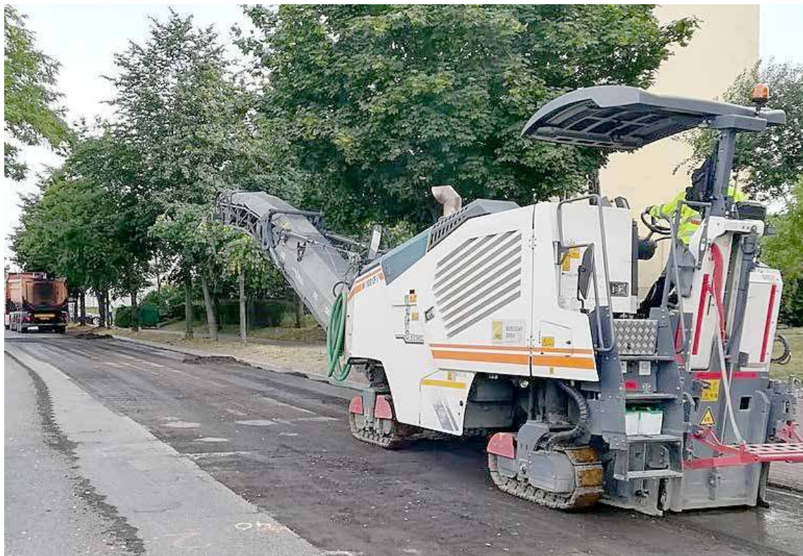
W tym roku nastąpi kontynuacja prac na kolejnym odcinku ulicy 15 Lutego
