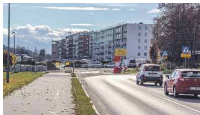
Budowa pierwszej obwodnicy przy Polanie Szaflarskiej już ruszyła.
