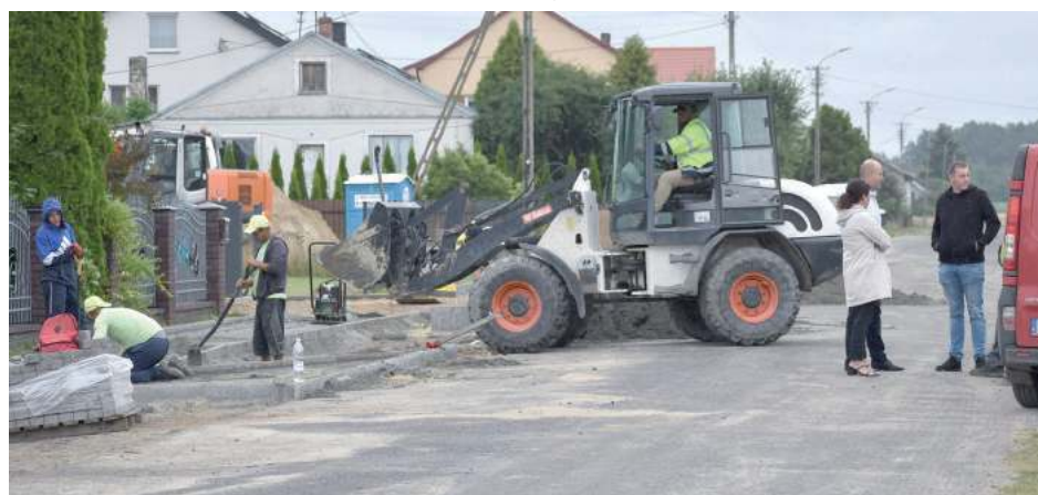
Prace przy drodze w Brzozowicy Dużej rozpoczęto od budowy chodnika
