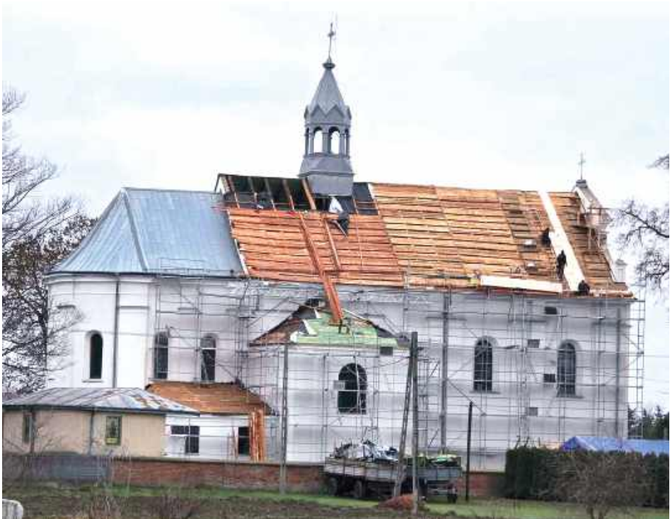
Wszystkie elementy zabytkowej więźby dachowej są poddawane ocenie stanu technicznego, a w przypadku złego stanu są naprawiane bądź wymieniane w niezbędnym zakresie oraz impregnowane
