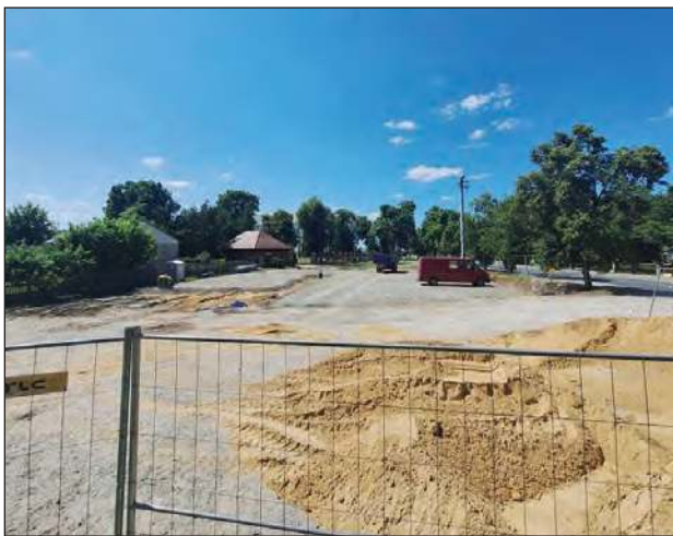
■ Pierwszym etapem jest zagospodarowanie ogólnodostępnego parkingu przy kościele w Maciejowicach
