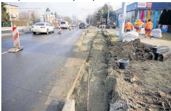
Utrudnienia w ruchu na al. Kraśnickiej. Prowadzone są prace w zatokach przystankowych
