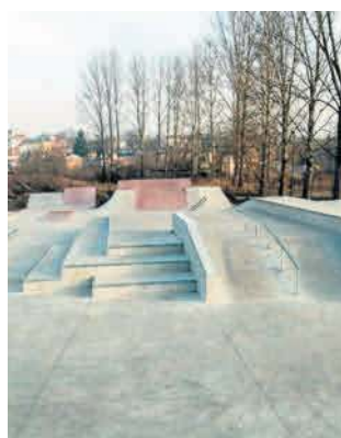
Skatepark powstał w ramach budżetu obywatelskiego. Koszt budowy - 2,4 mln zł
