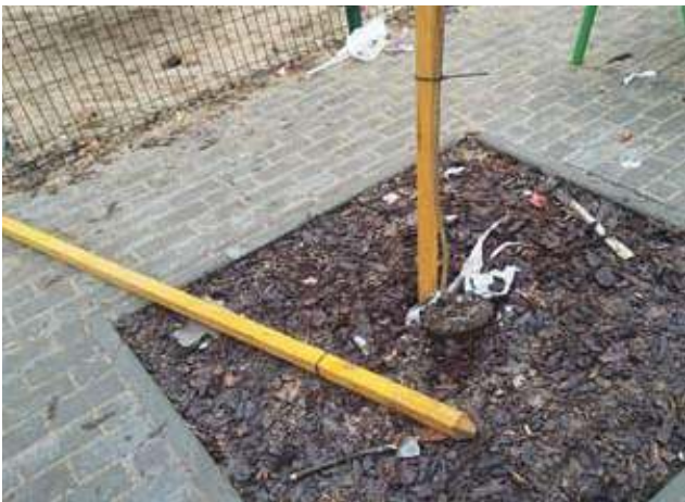
Zniszczenia na nowym placu zabaw w Lubiążu
