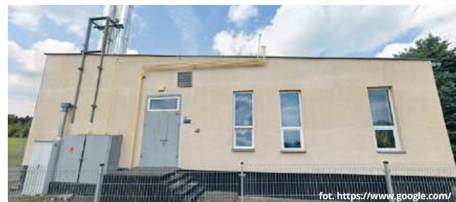
Obiekt ciepłowni miejskiej w Rejowcu Fabrycznym, która zlokalizowana jest przy ul. Wschodniej
