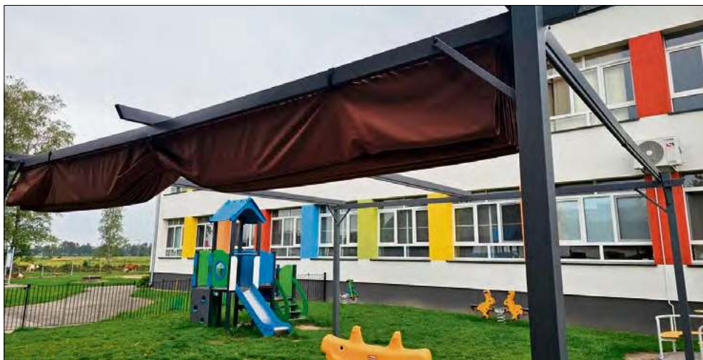
Piaskownica przy szkole w Dębciu została zadaszona.
