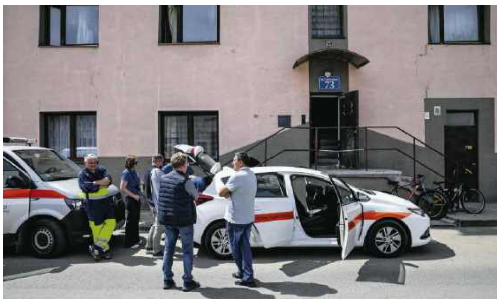
• Samowola budowlana przy ul. Centralnej 73B. Na zdjęciu PINB i próba rozpoczęcia rozbiórki 5 maja 2026 roku FOT. JAKUB WŁÓDEK / AGENCJA WYBORCZA.PL
