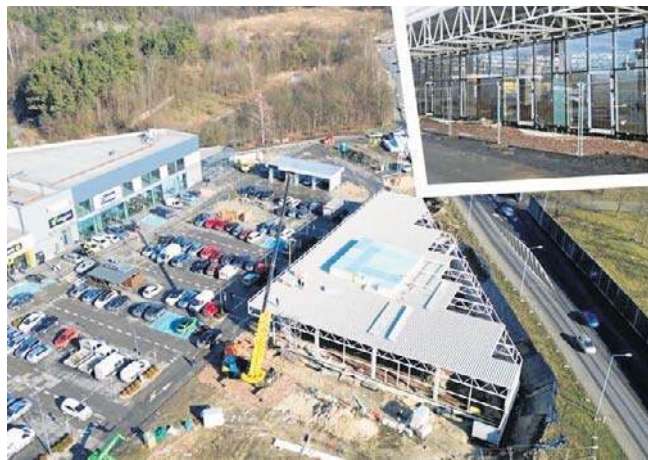
Kasztelania. Po zamknięciu konstrukcji przed wykonawcami pozostają prace instalacyjne wewnątrz nowego budynku
