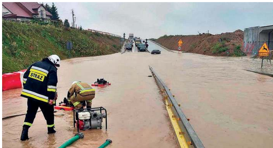
Odcinek DK7 był całkowicie zalany. Generalna Dyrekcja Dróg Krajowych i Autostrad zapowiada działania naprawcze
