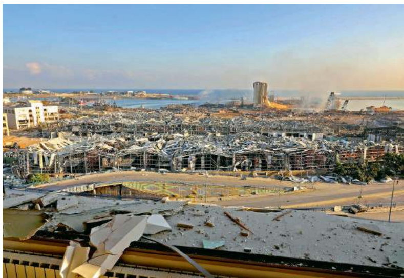
Skala zniszczeń po wybuchu jest ogromna.
