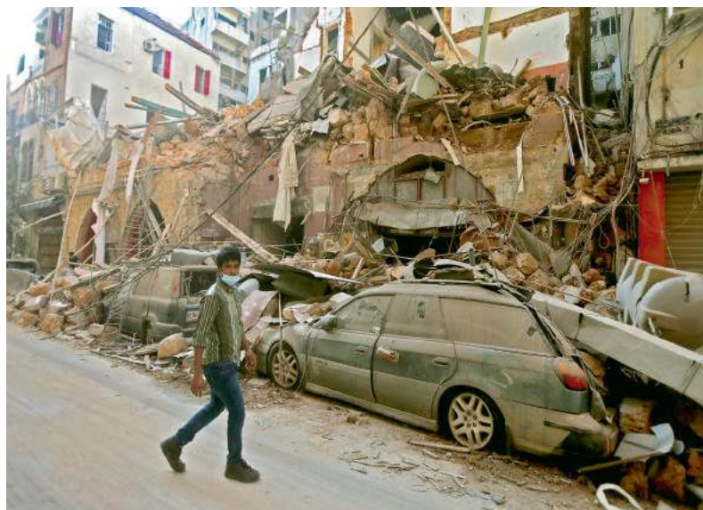
Tysiące budynków zostało całkowicie zniszczonych.
