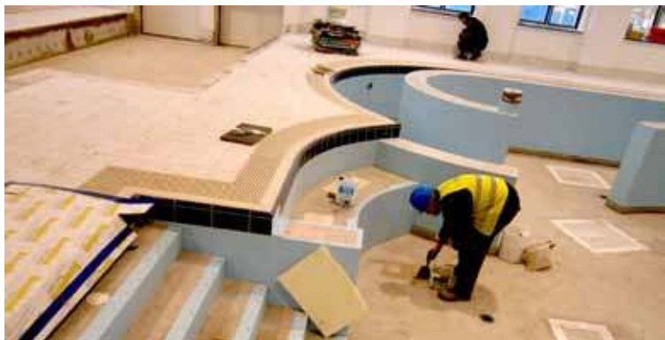
W basenach prowadzono prace glazurnicze
