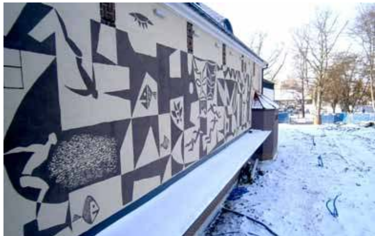
W lutym wykonano prace związane z elewacją budynku
