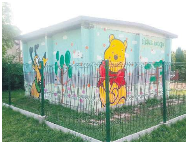
Bajkowa stacja trafo.
