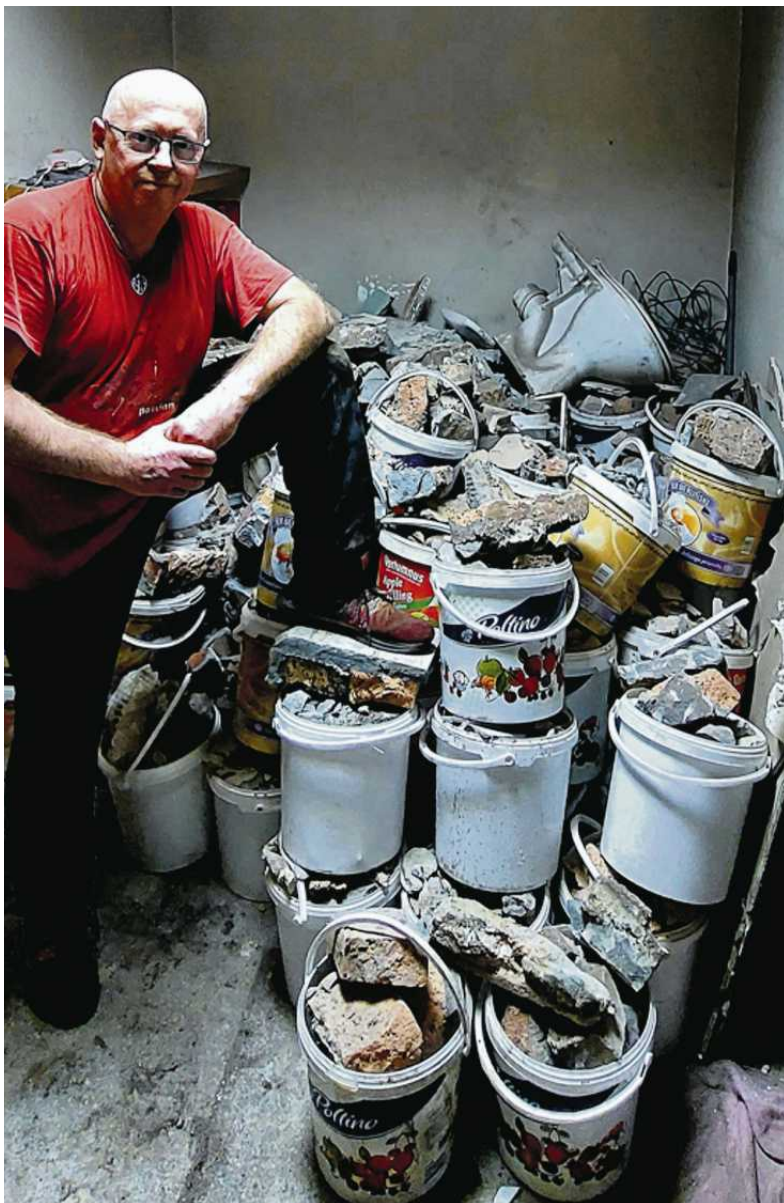
• Jarosław Dudek w trakcie remontu lokalu przy ul. Kościuszki w Będzinie
