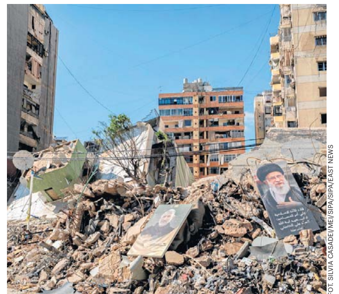
Zniszczone budynki na południowych przedmieściach Bejrutu. Tysiące mieszkańców po atakach trwających od marca zostało zmuszonych do opuszczenia swoich domów
