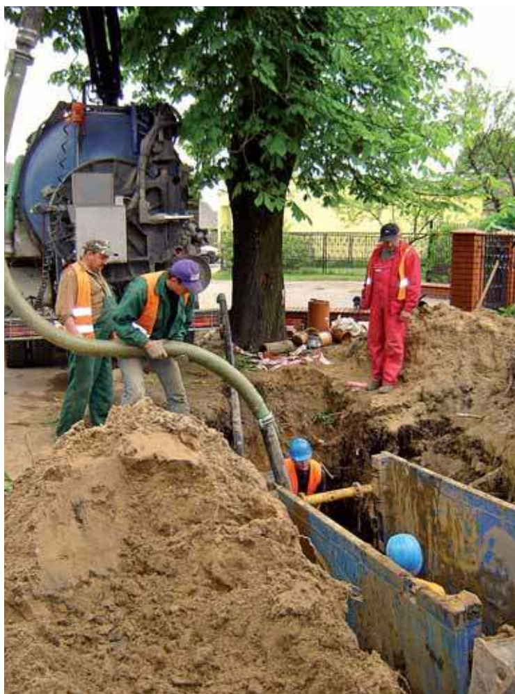
W poprzednich latach dzięki środkom unijnym możliwa była budowa sieci kanalizacyjnej w gm. Łaskarzew
