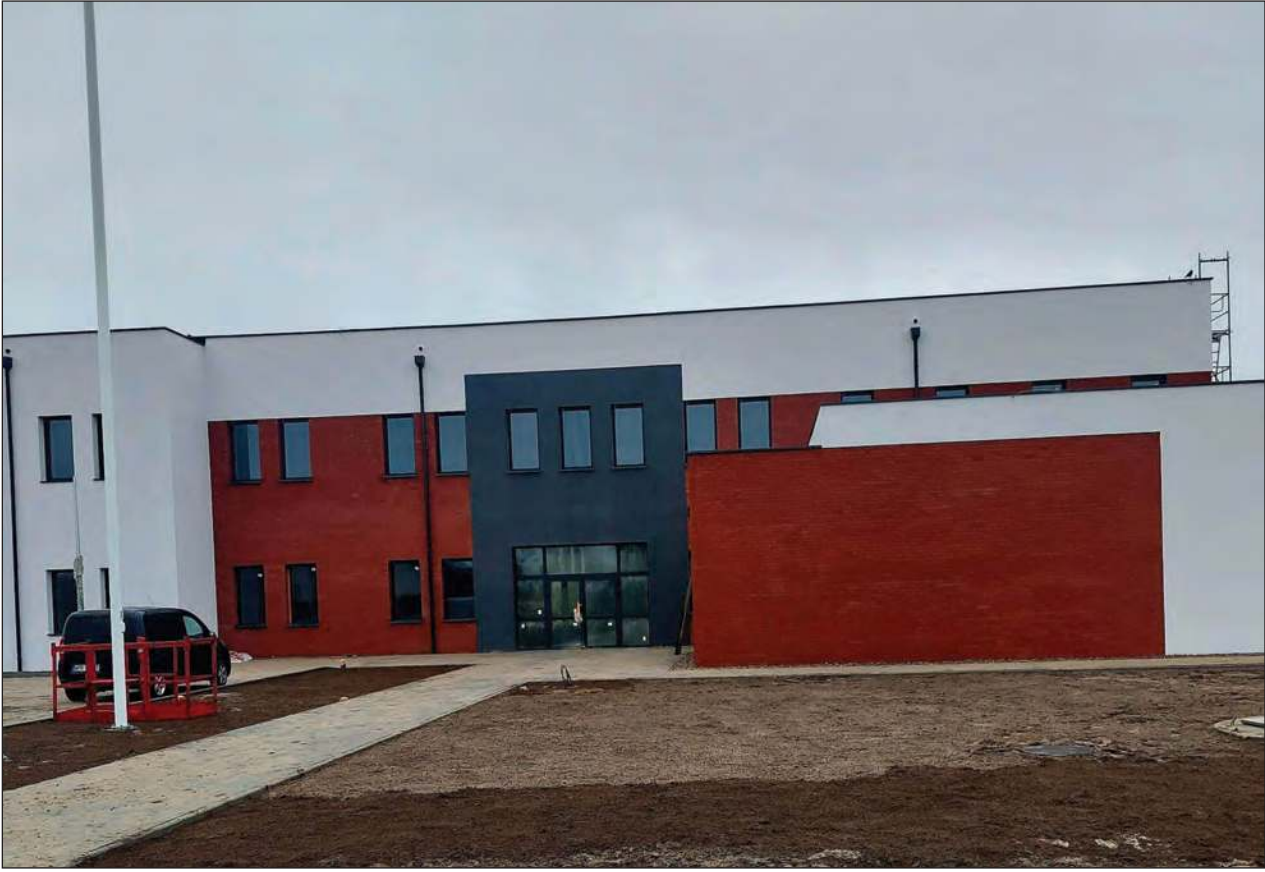
✚ Budowa nowego urzędu gminy zakończy się okresie maj-czerwiec. Jego otwarcie jest zaplanowane na lipiec. Jest szansa na to, że od nowego roku budynek będzie siedzibą urzędu miasta i gminy
