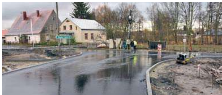
Prace w Borowie powoli dobiegają końca (fot. powiat nowosolski)
