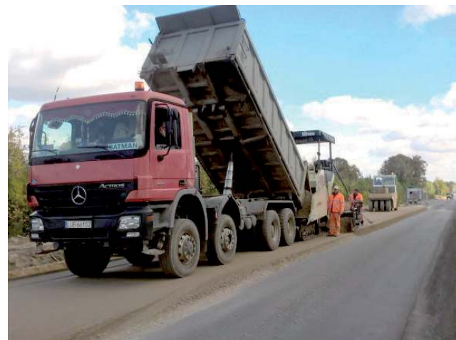
Na remontowanym odcinku jezdni jest poszerzana do 7 m z jednoczesnym wzmocnieniem jej konstrukcji
