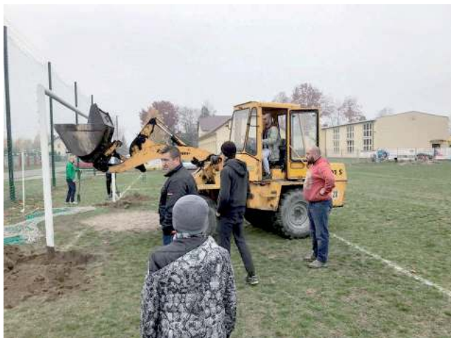
Boisko w Rzeczycy przypomina plac budowy. Zniknęły bramki, ławeczki
