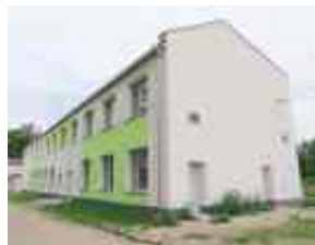
Budynek po dawnej szkole przeszedł termomodernizację
