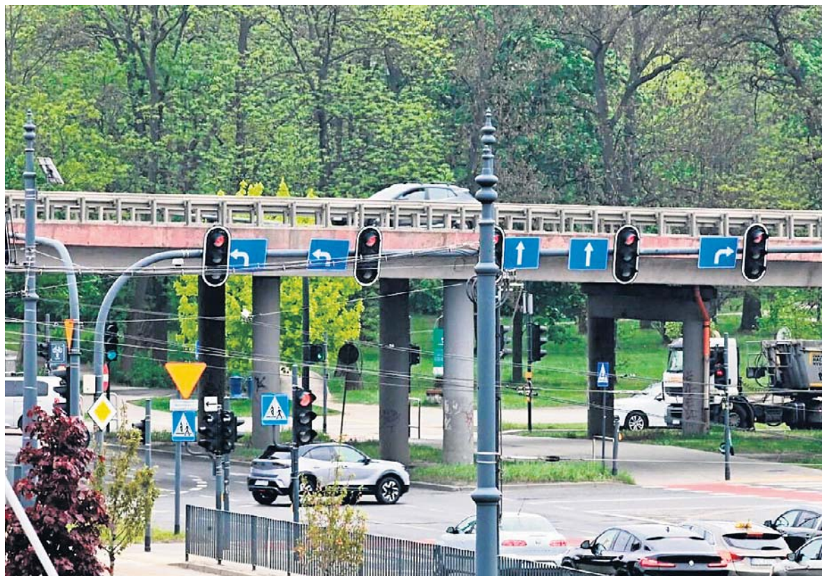
Estakada na Alei Włókniarzy ma już 30 lat, od kilku lat niepokoiła swym wyglądem i stanem technicznym. Czas na remont. Konstrukcja ma ponad pół kilometra długości, a roboty obejmą każdy jej element
