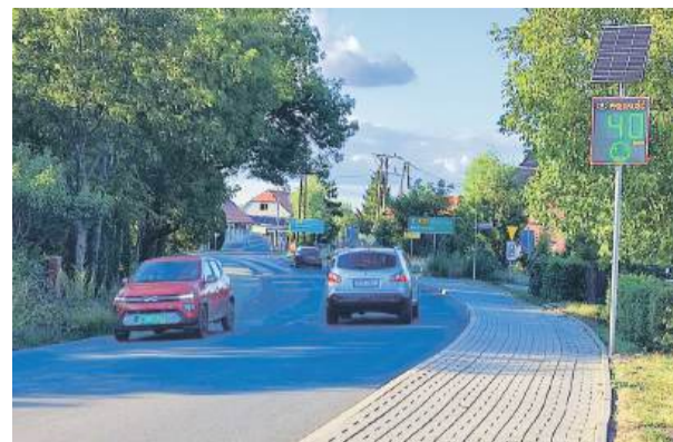
Radarowe tablice prędkości stanęły na wjazdach do miejscowości przy drodze nr 395
