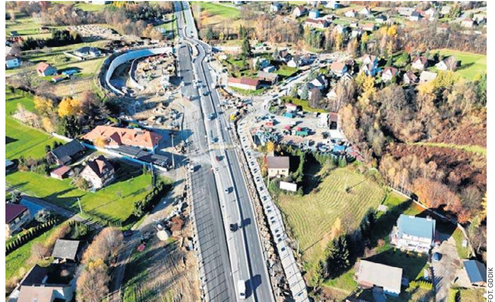
W Krzyszkowicach wokół węzła drogowego powstaną drogi dojazdowe wzdłuż zakopianki
