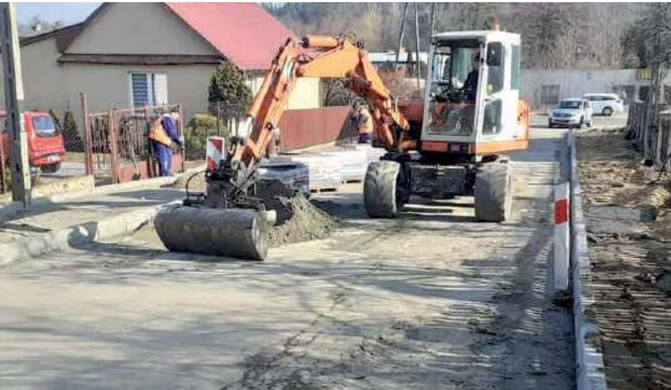
Remont ul. Letniej. Zakres prac obejmuje wymianę chodników, zjazdów i nawierzchni
