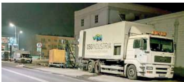
Trwa renowacja i uszczelnienie kanałów sanitarnych w Łukowie
