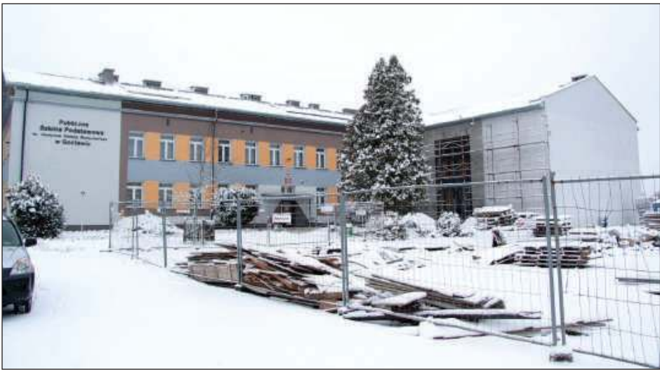
■ Gmina Pilawa już po raz drugi składa wnioski covidowe i po raz drugi zgłasza do dofinansowania zadanie, związane z przebudową szkoły podstawowej w Gocławiu
