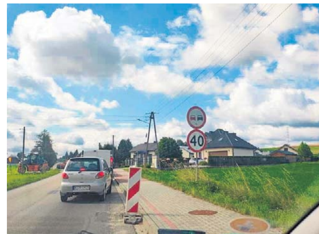
Coraz mniej brakuje do zamknięcia kolejnego odcinka pieszej trasy prowadzącej w stronę Gorlic
