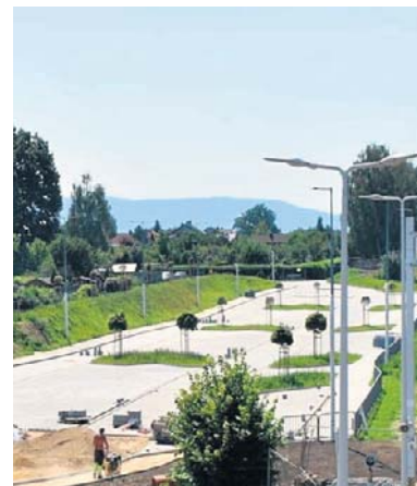
Budowa parkingu zbliża się do finału
