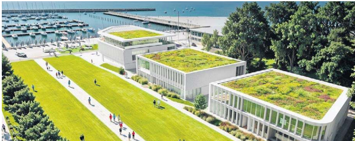
Inwestycja zakłada budowę trzech budynków o łącznej powierzchni użytkowej około 3500 m kw.
