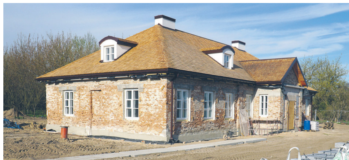
Dach został pokryty tradycyjnym gontem.
