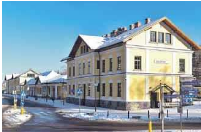
Remont dworca PKP w Zakopanem - to jedna z inwestycji finansowanych z unijnych pieniędzy.
