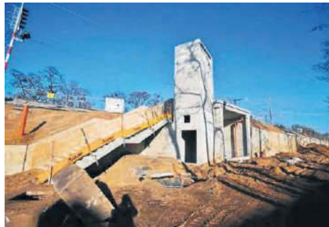
Przy ul. Długiej powstaje przystanek kolejowy Wrocław Szczepin. Obok będą przystanki tramwajowe i autobusowe
