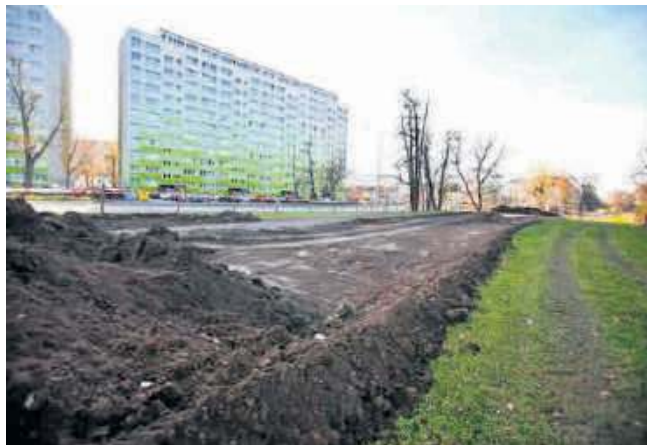
Rozpoczęły się już roboty od końca ul. Długiej w stronę mostu Milenijnego. Cała trasa ma mieć ok. 4 km długości
