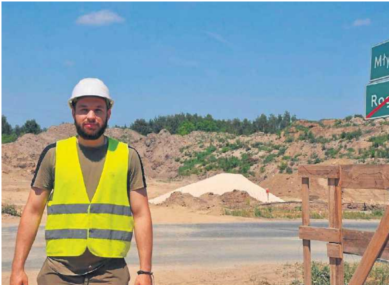
Inżynier budowy, Błażej Stępień, pokazał nam stan budowy pierwszego odcinka obwodnicy Końskich.
