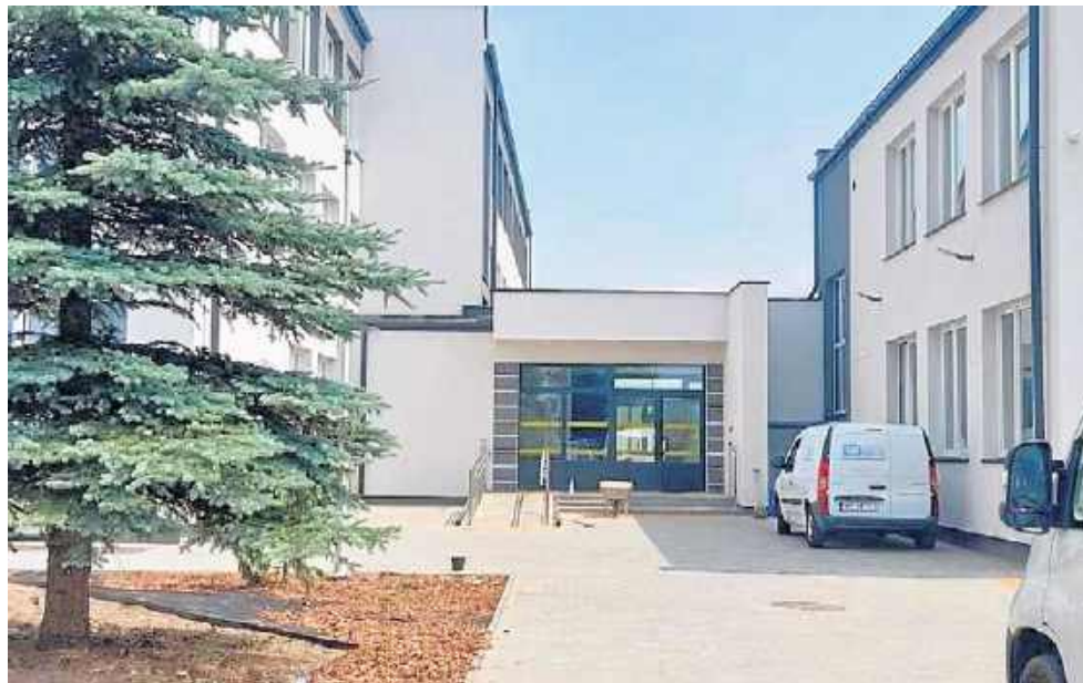
Wygląd szkoły przy ulicy Wierzbickiej po przebudowie robi duże wrażenie. Kto pamięta, jak wyglądała jeszcze niedawno może to potwierdzić.
