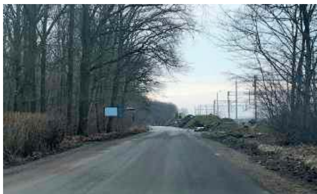
Kontynuacja przebudowy ulicy Dworcowej uzależniona jest od dofinansowania z programu Polski Ład
