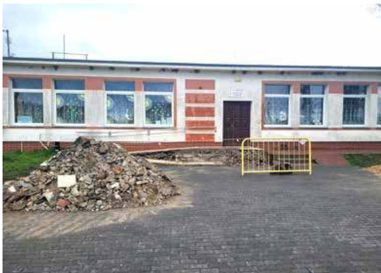
W miejscowości Dzwonowo trwają prace związane z remontem schodów i podjazdu do świetlicy wiejskiej
