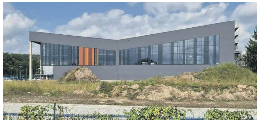
(E) Tak obecnie wygląda powstająca kryta pływalnia w Krzeszowicach
