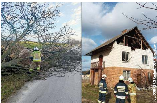
Z lewej powalone drzewo w Płonce, z prawej zawałona część ściany szczytowej domu w Wólce Kraśnickiej.
