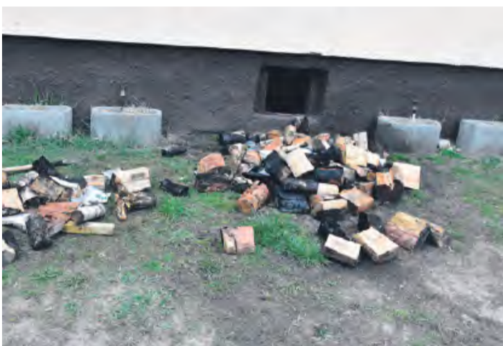
W zdarzeniu ucierpiały pomieszczenia piwniczne. Reklama
