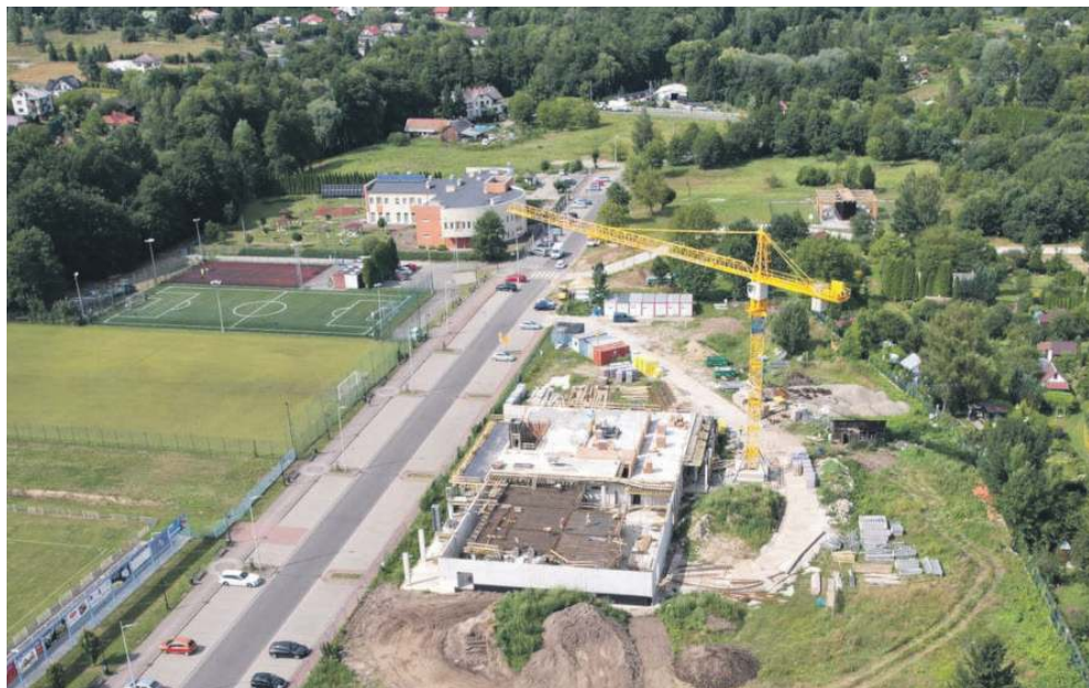
Trwa budowa basenu w Krzeszowicach
