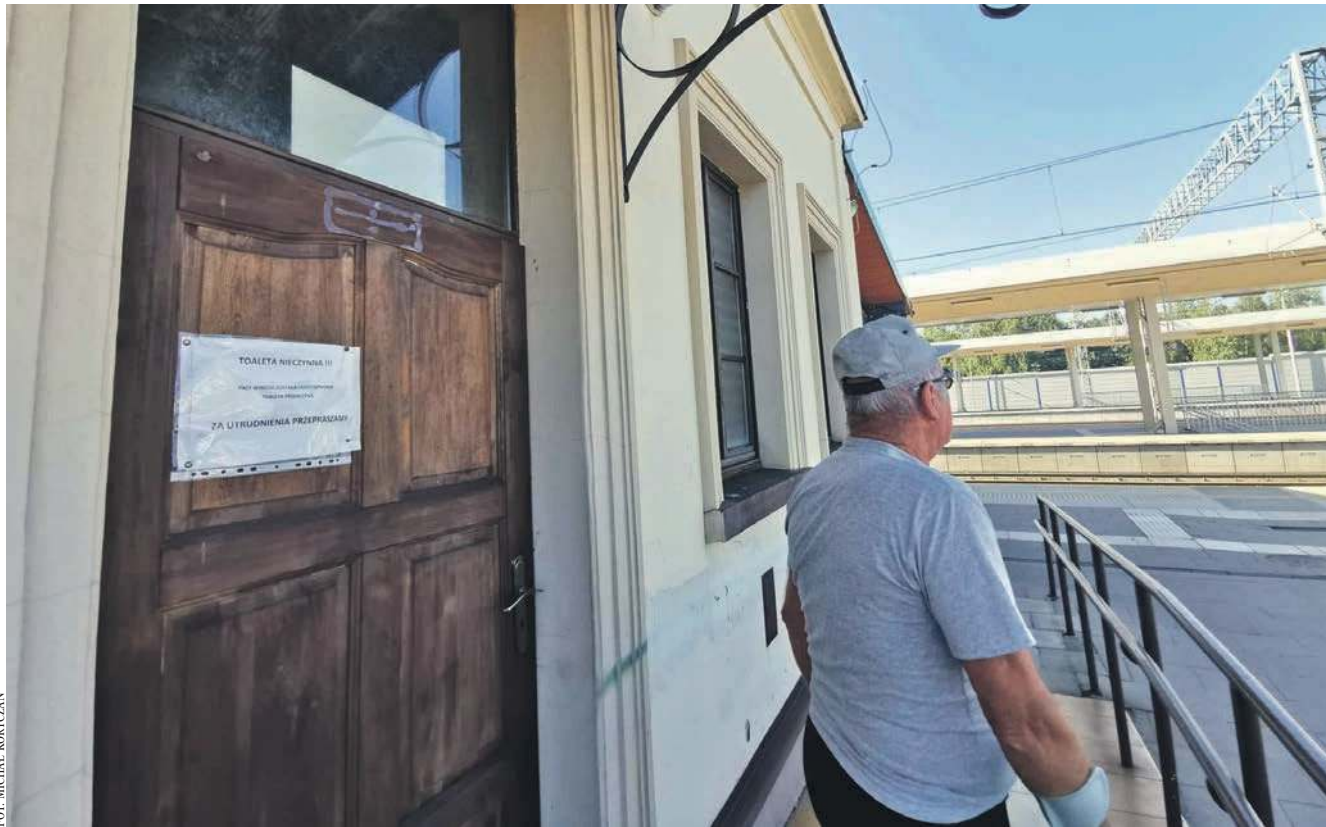
Toaleta publiczna w budynku dworca kolejowego w Trzebini pozostaje nieczynna
