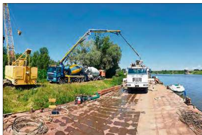
Prace na śluzie są widoczne z portu jachtowego.
