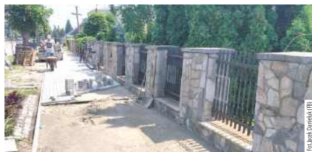
Praca wre przy układaniu nowej kostki chodnikowej na Wojska Polskiego
