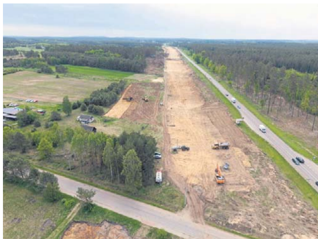
Początkowa faza budowy odcinka drogi ekspresowej. Zabudowania, które stoją na drodze trasy zostaną wyburzone
