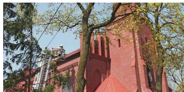
Zastęp OSP Wyszyny Kościelne niezwłocznie pojawił się na miejscu zdarzenia
