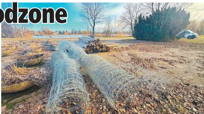
Prace na płońskich Rutkach już się rozpoczęły
