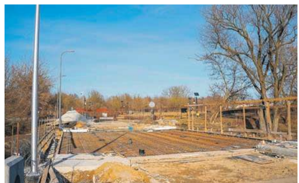
Budowa mostu na Łydni
