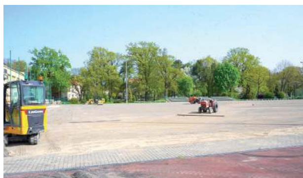
Prace trwają również na obiekcie przy ul. Kaniowczyków przy ZSO im. KEN. Boisko jest wyłączone z użytkowania
