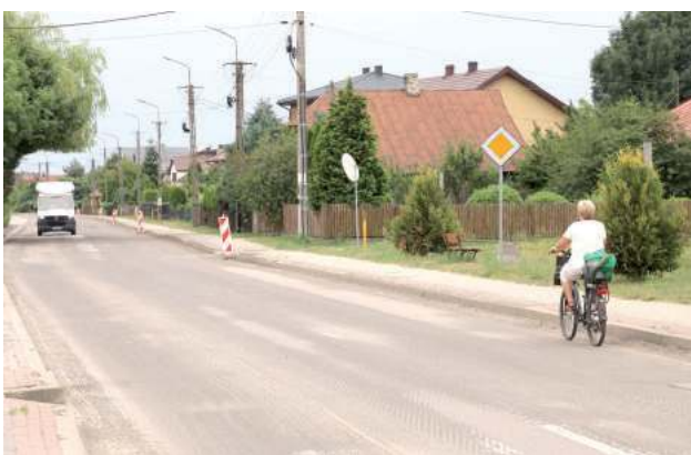
Trwa remont ulic w Adamowie (fot. Patryk Pytlak)
