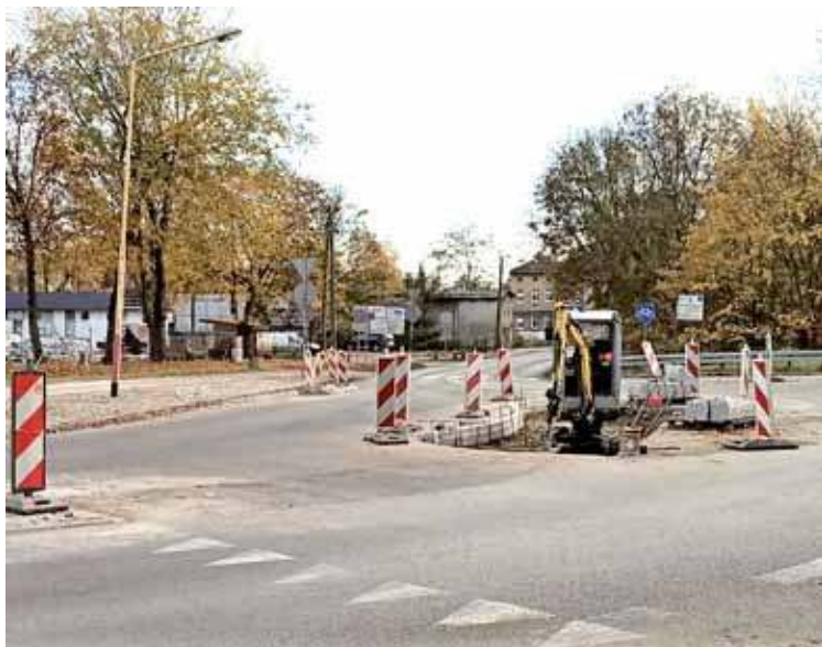
Rozebrano już nawierzchnię bitumiczną. Teraz położona zostanie podbudowa a następnie kostka brukowa i obramowanie z krawężników.
