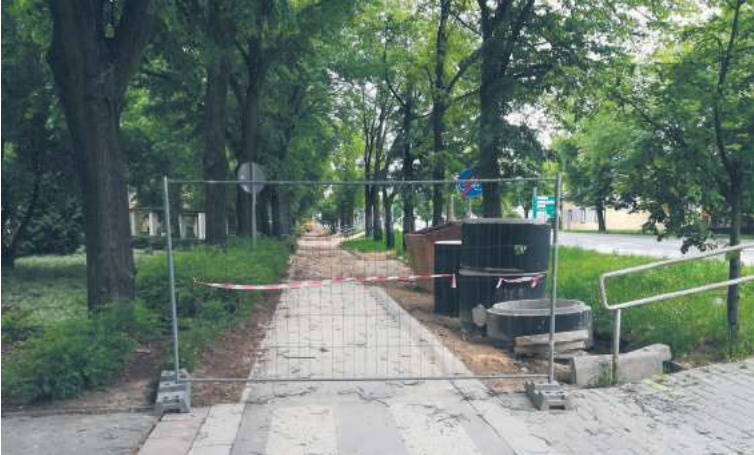
Brakujący fragment ścieżki zostanie dobudowany
