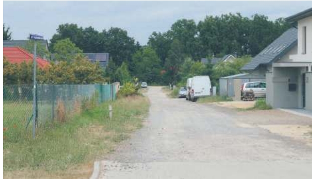
Na ulicy Poziomkowej wkrótce pojawi się nie tylko asfaltowy dywanik, ale również oświetlenie
