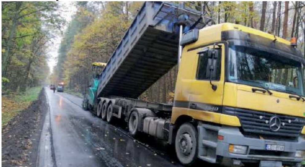
Remont drogi kosztował prawie 124 tys. zł
